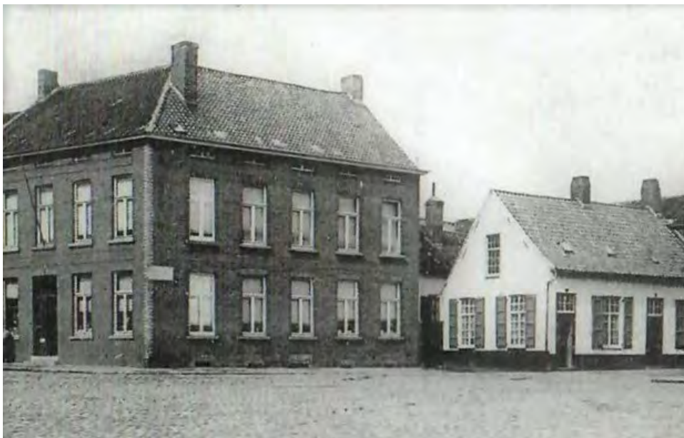
Afb. 4. Links het hoekhuis van de familie Muylle op de Zwijnsmarkt (nu Botermarkt). De schoorsteen tussen het hoekhuis en het witte huis was vermoedelijk de schoorsteen van de pottenbakkers- en pijpenbakkersoven Muylle.
